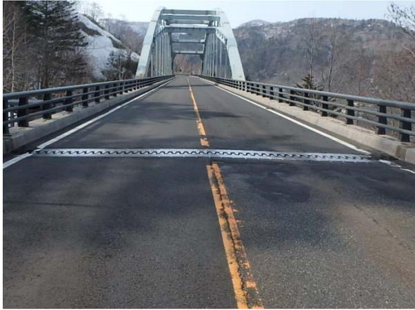
写真-2 段差擦り付け前の伸縮装置付近の状況
