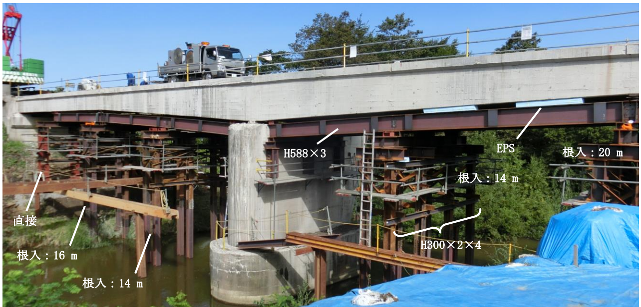
図-4 ベントおよび縦桁
