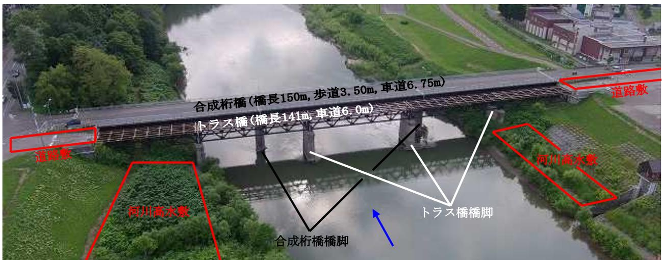
写真1 トラス橋の施工条件
