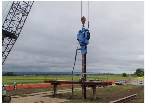
写真-3 仮設杭打込み状況
