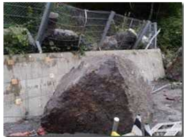
図-2 巨石、落石による破損例
