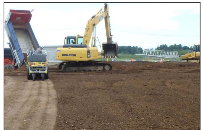
図-3 盛り土の敷き均し
