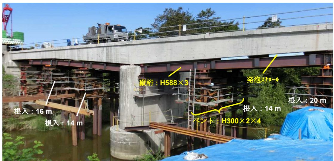
図-10 ベントおよび縦桁
