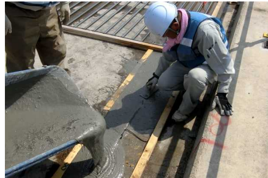
(b) 高強度モルタルの打設
