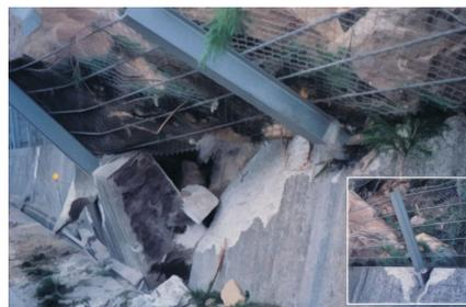
写真-1 支柱基部の損傷例<sup>3)</sup>
