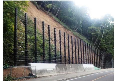
写真-1 土砂堆積用支柱フェンス
