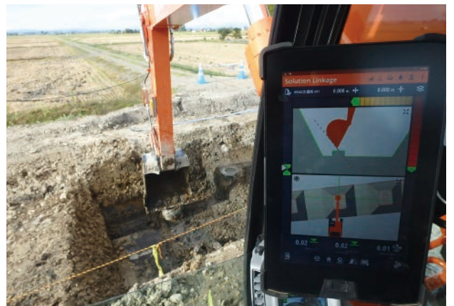
写真2 MC(マシン・コントロール)によるICT土工
