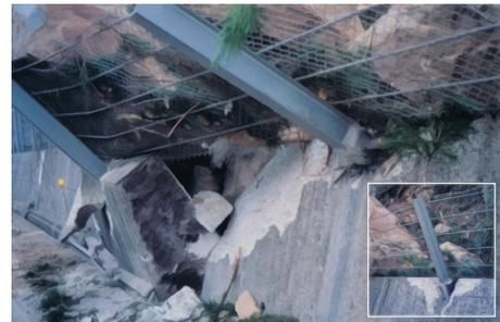
写真-1 支柱基部の損傷例
