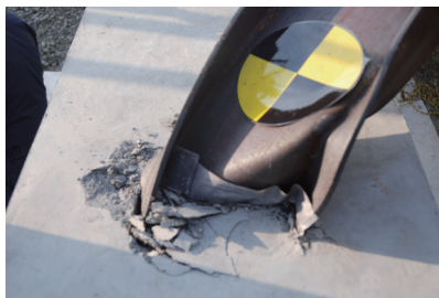
(c) PS 試験体の基部の変形状況-1
