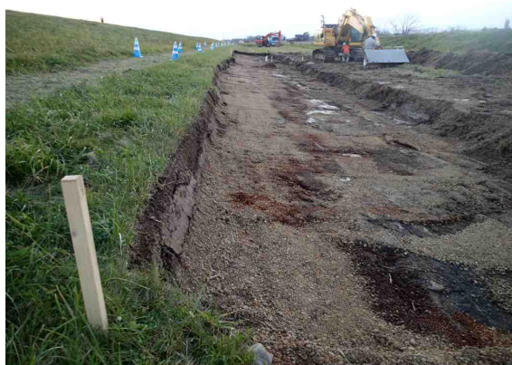
写真-5 条件E(未経験者MG)の出来形
