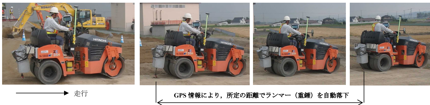
図-3 衝撃加速度法の自動化
