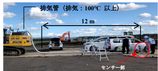
図-1 バックホーCO 2 排出量測定状況
