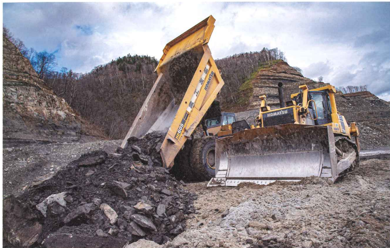
採掘後の埋め戻しでは、HD605大型ダンプトラックが土砂を運搬し、コマツの大型ブルドーザD275AXが敷き均し、山を回復させていた
