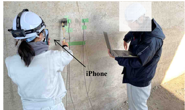
図-1 橋脚における打音試験状況
