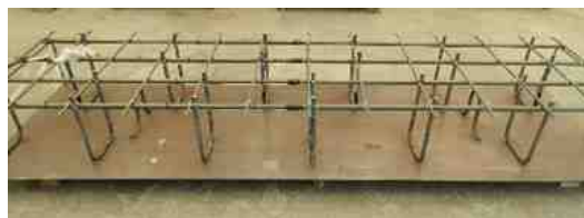
写真-1 ずれ止め筋配置状況
