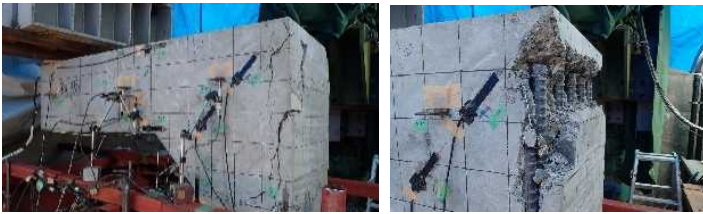
写真-1~2 隅角部破壊状況と鉄筋露出状況
