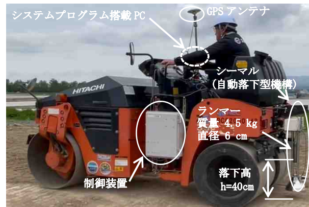
図-3 ローラーの装着状況
