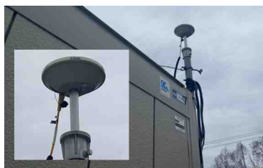
図 11：現場事務所に設置したオリジナル電子基準
