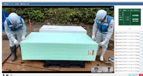
図 9：山間部現場における遠隔臨場
