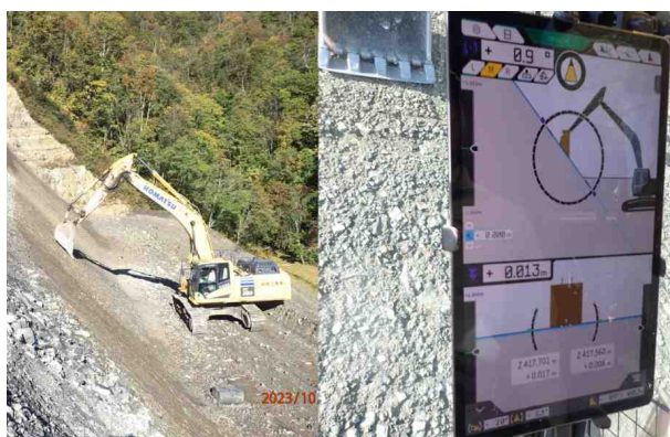
図 8：Ntrip 補正情報を受信して MG
