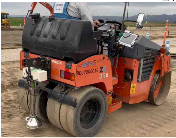
図-2 リアルタイム締固め測定機搭載ローラー
