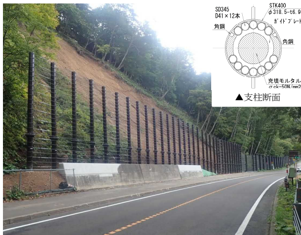
写真-1 土砂堆積用支柱フェンス
