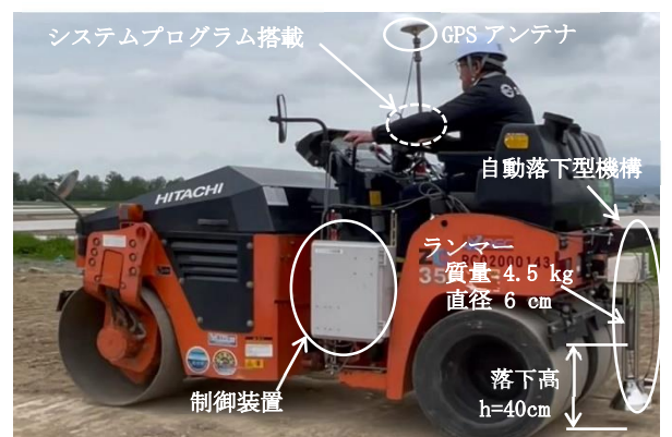
図-2 ローラーの装着状況
