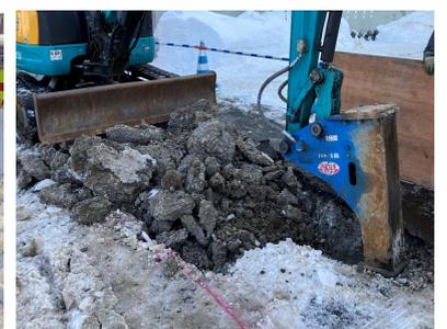
写真3 ブレーカ掘削
