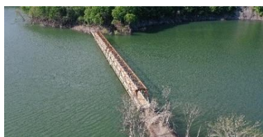
写真-1 現道状況
