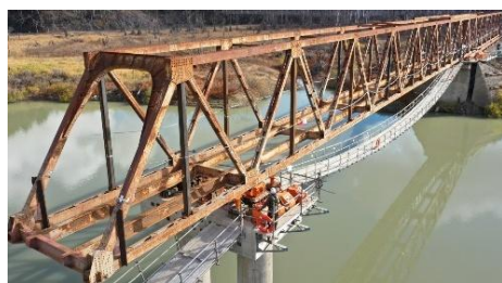
写真-6 補強後のトラス橋
