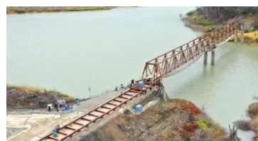
写真-2 橋台背面の施工ヤード
