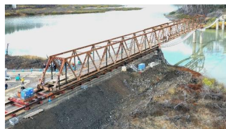
写真-7 トラス橋引き込み状況
