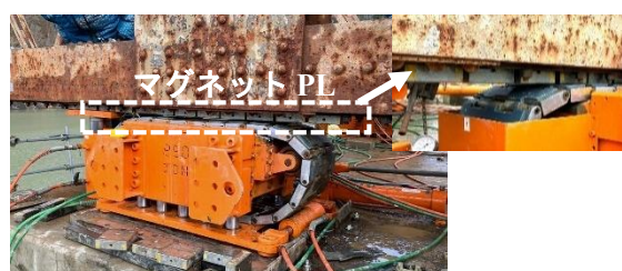
写真-3 シンクロジャッキ
