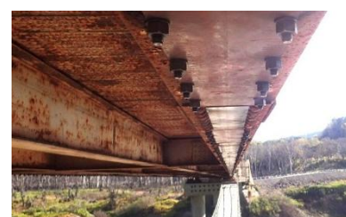
写真-5 下弦材下面状況
