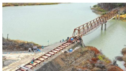
写真-2 橋台背面の施工ヤード
