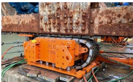
写真-4 シンクロジャッキ
