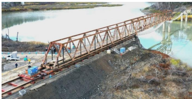
写真-7 トラス橋引き込み状況
