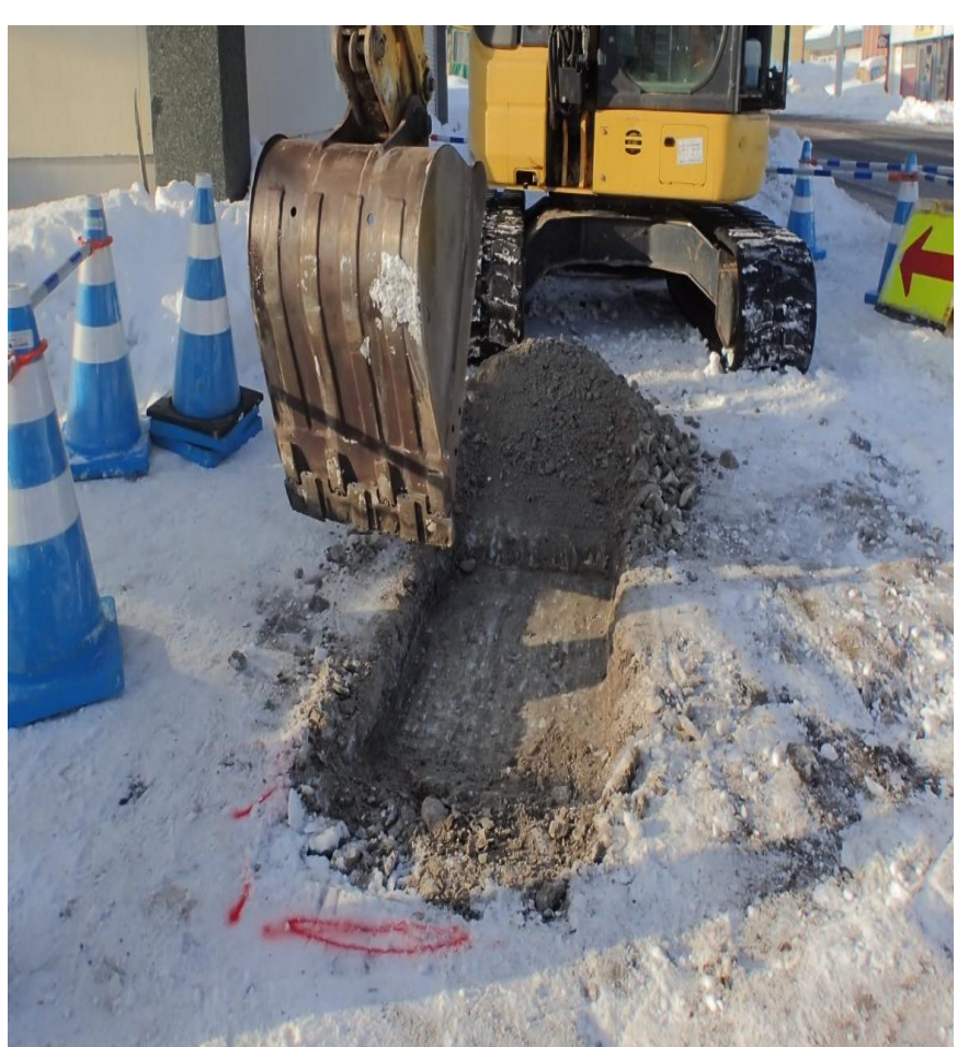
写真-2 通常バックホウ掘削
