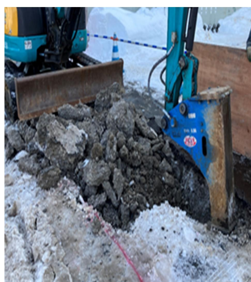
写真-3 ブレード掘削
