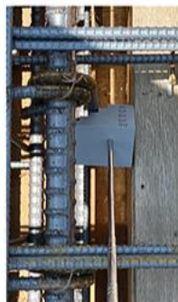
鉄筋空きチェック
